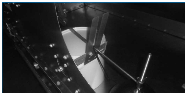
Umieszczenie materiałów montażowych
