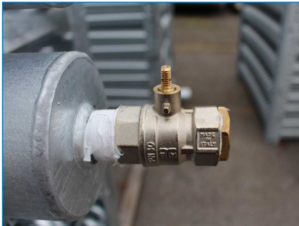
Övre slingkoppling med övertrycksventil på slutna krets kyltorn med anslutningar upp till ND 100.
