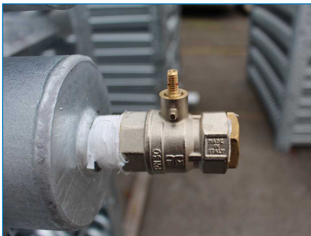
Övre slingkoppling med övertrycksventil på slutna krets kyltorn med anslutningar upp till ND 100.
