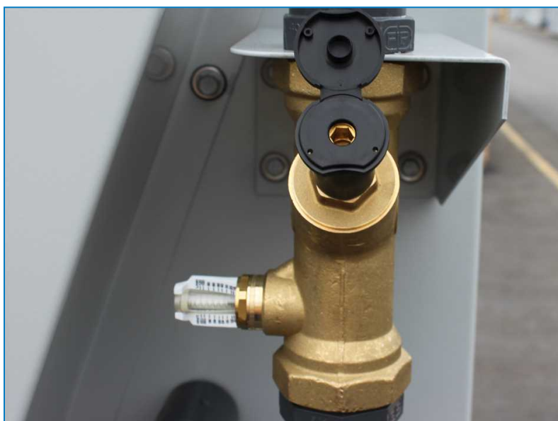
Vite di regolazione portata dell'acqua
