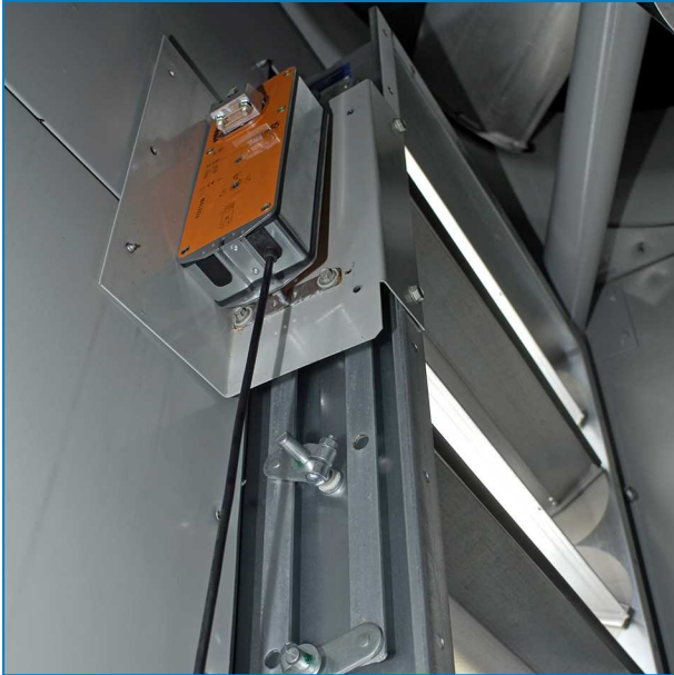
Attuatore per serrande per la modulazione dell'entrata aria
