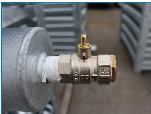
Raccord de batterie non fileté avec soupape de décharge sur l'unité d'accumulation de glace pour l'alimentation directe en réfrigérant.
