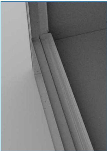
Canalón de recogida de agua
