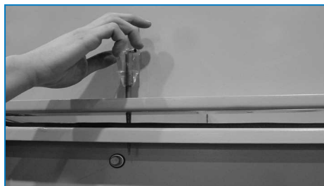
Použití vodícího kolíku pro nastavení otvorů pro šrouby do souosé polohy
