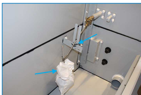
Montaż i owijanie kuli pływaka
