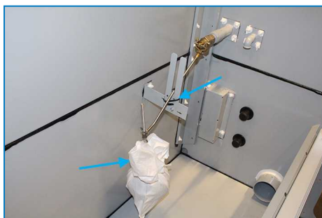
Montaż i owijanie kuli pływaka
