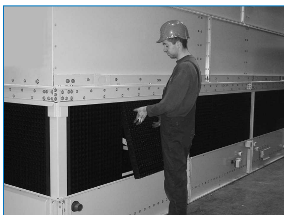
Usuwanie zespolonych osłon wlotowych
