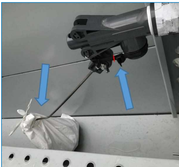
Montaż i owijanie kuli pływaka
