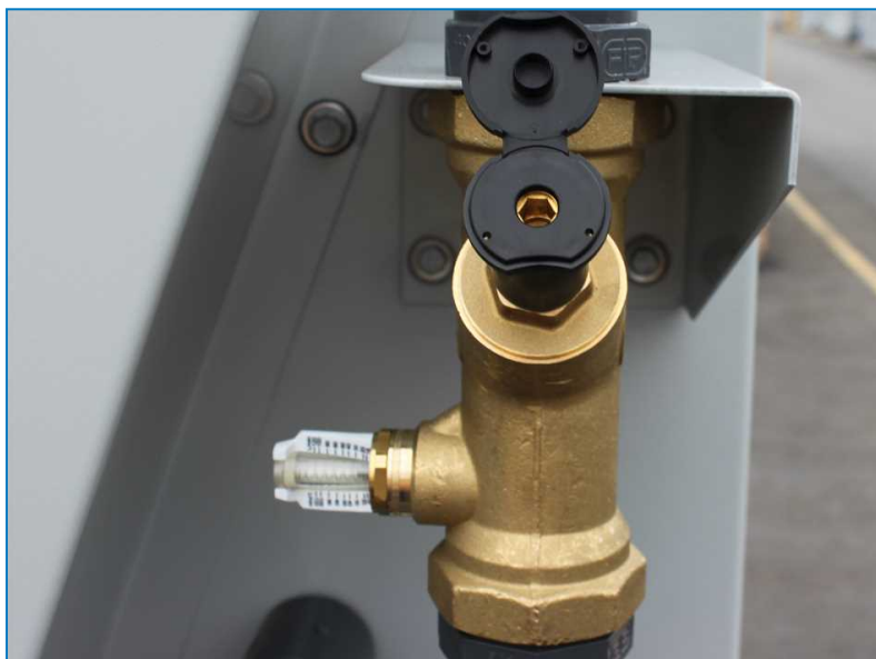
Vízáramlás-beállító csavar
