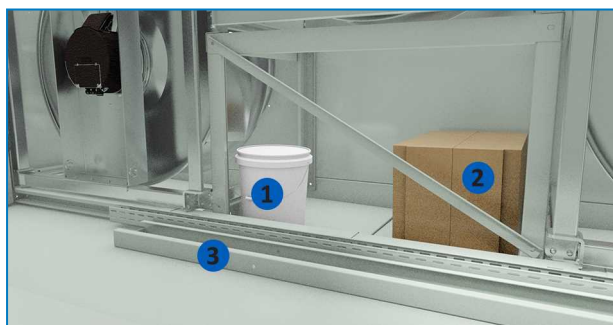
Posizione della bulloneria, della pompa e del supporto pompa (se spediti non montati)
