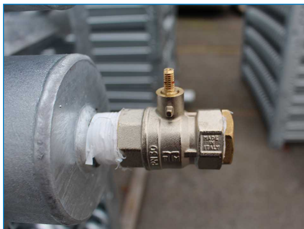
Felső csőköteg-csatlakozás nyomásmentesítő szeleppel kondenzátorok.
