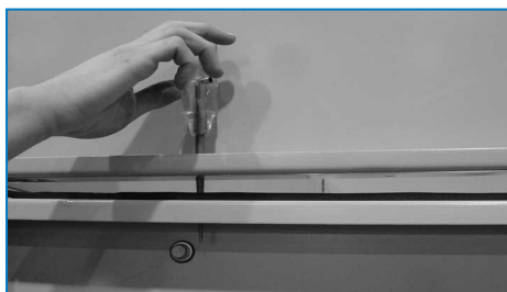
Csavarlyukak igazítása lyukasztőtüskék segítségével
