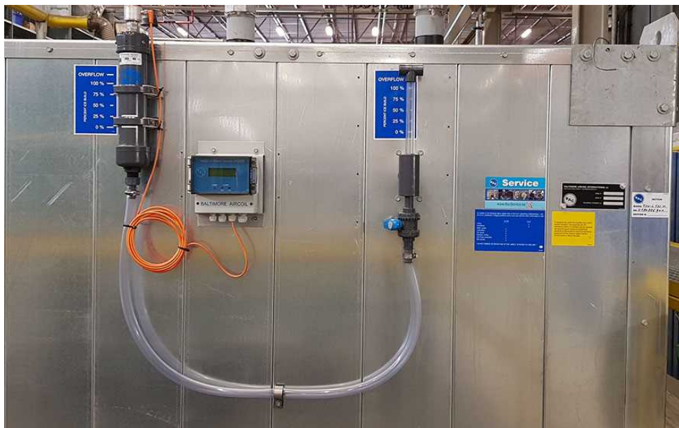
Контроллер Ice Logic™ с радарным датчиком
