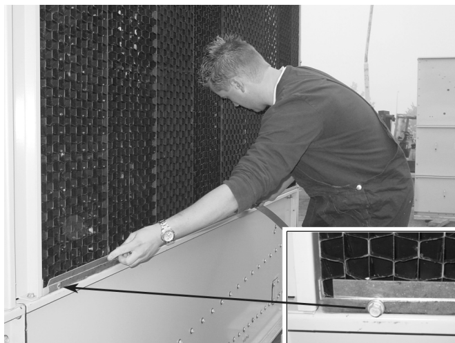
9. Rysunek : Usuwanie pasów zabezpieczających
