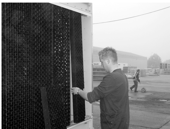
10. Rysunek : Usunąć zespolone osłony wlotowe
