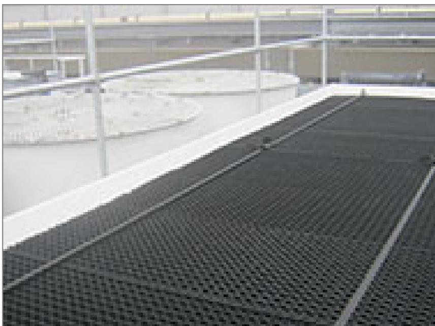
Schermi d'ingresso dell'aria superiori combinati bloccano la luce del sole, prevengono la crescita biologica all'interno dell'unità, filtrano l'aria e bloccano gli spruzzi d'acqua verso l'esterno. Schermi d'ingresso aria superiori
