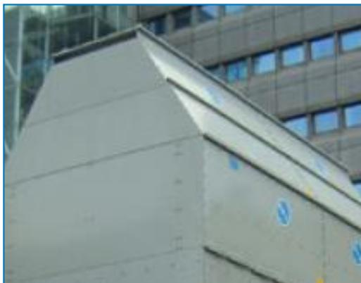
Los plénums de descarga **reducen el riesgo de recirculación en recintos estrechos**, aumentando la velocidad del aire de descarga, y se pueden utilizar para elevar la salida de aire del equipo sobre muros adyacentes, para cumplir con las directrices de diseño. [Siga leyendo](#)
