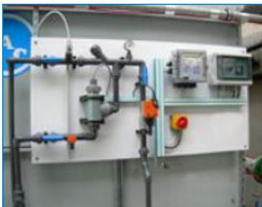
Los dispositivos para el tratamiento de agua de control son necesarios para garantizar un **cuidado adecuado del agua de la torre de enfriamiento**. No solo ayudan a proteger los componentes y el paquete de relleno, controlando la corrosión, la formación de incrustaciones y la suciedad, sino que también evitan la proliferación de bacterias dañinas, como **legionela**, en el agua de recirculación. [Siga leyendo](#)
