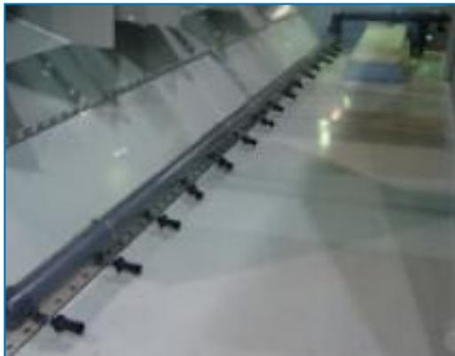
El sistema de filtración de la balsa **evita que los sedimentos se depositen en la balsa de agua fría** de la unidad. Se instala un sistema completo de tuberías, incluyendo pulverizadores en la balsa de la torre para **conexión a la unidad de filtrado**. [Siga leyendo](#)
