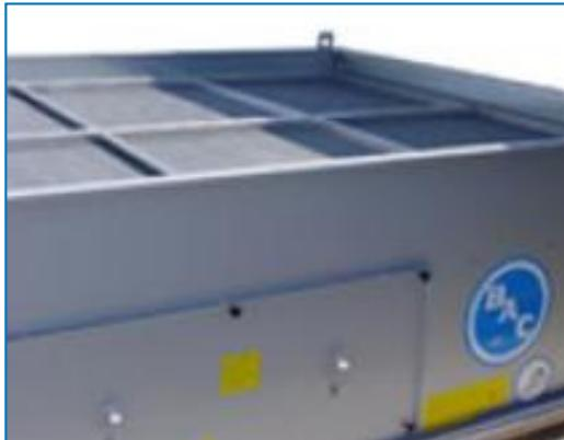
En la impulsión de su torre de enfriamiento se instala una batería de impulsión aleteada que se conecta en serie con la batería húmeda. Esto **reduce o elimina los penachos**. [Siga leyendo](#)
