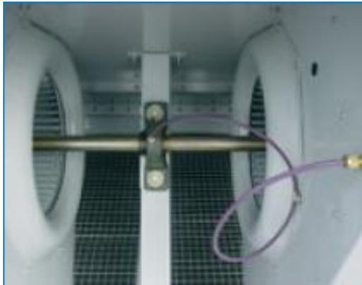
Las tuberías de engrase prolongadas con engrasadores fácilmente accesibles pueden utilizarse para **lubricar** los rodamientos del eje del ventilador. [Siga leyendo.](#)
