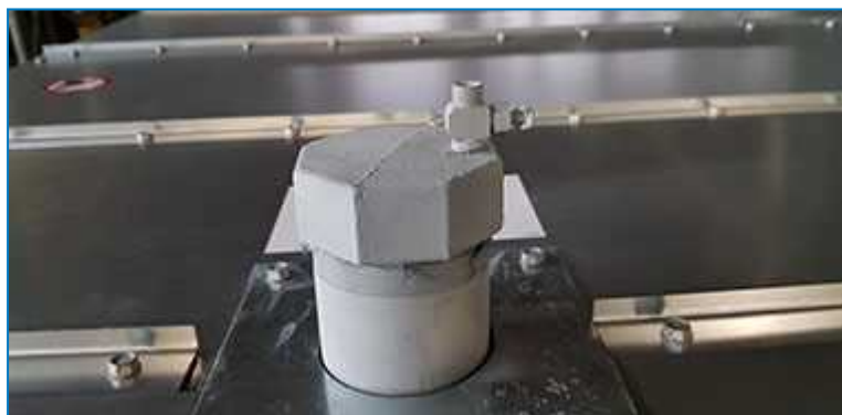
Резьбовое соединение теплообменника на льдоаккумуляторе
