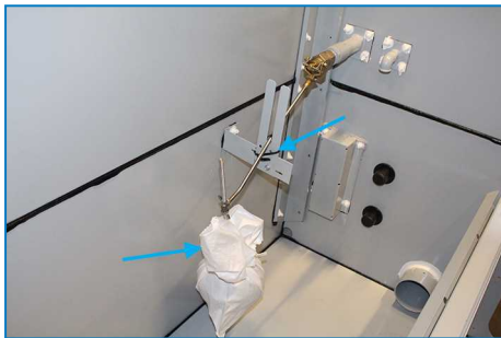
Befestigung und Umhüllung der Schwimmerkugel
