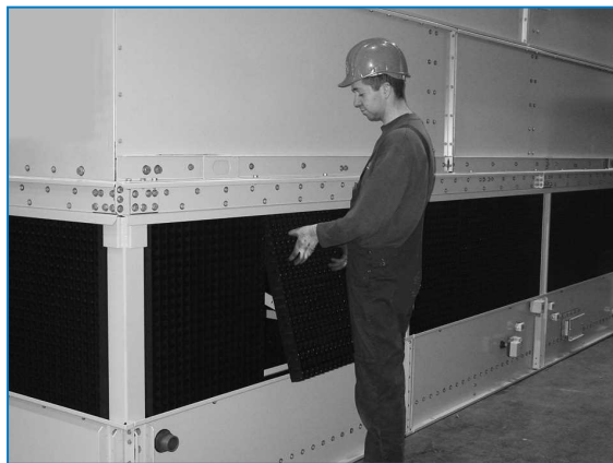
Kombinierte Lufteintrittsschutzelemente entfernen
