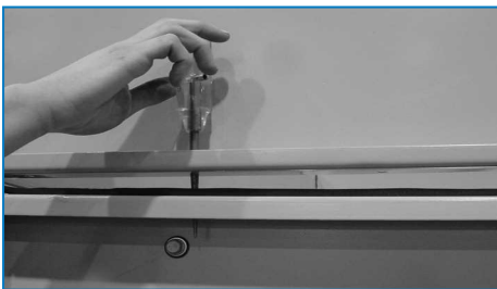
Verwendung des Treibdorns zur Ausrichtung der Schraublöcher
