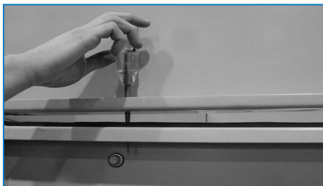
Verwendung des Treibdorns zur Ausrichtung der Schraublöcher
