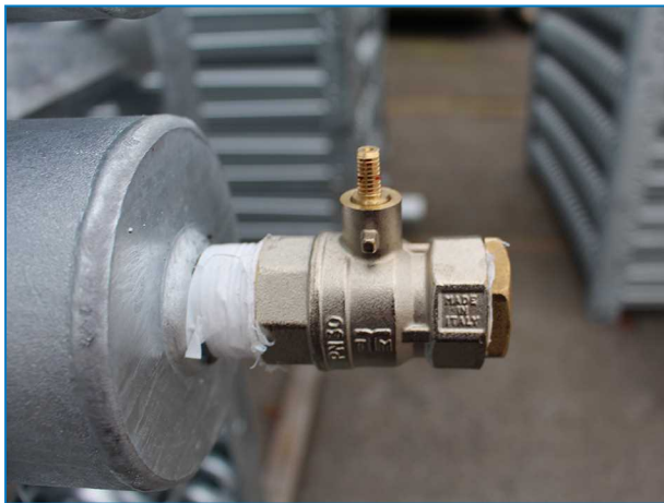
Oberer Rohrbündelanschluss mit Überdruckventil auf Verdunstungsverflüssigern.
