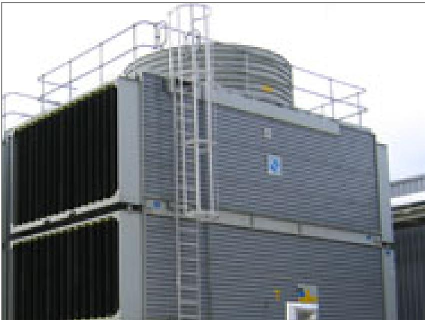
Eine Leiter, ein Sicherheitskorb und Geländer werden für den **problemlosen Zugang zur Oberseite des Geräts und die einfachere sicherere** Inspektion und Wartung in Übereinstimmung mit den **EU-Sicherheitsrichtlinien** installiert.
