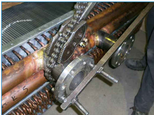
Установка фланцев с резьбовым соединением
