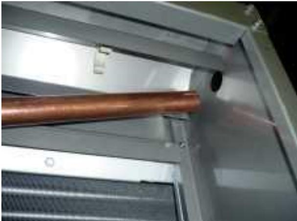
*Einbau der Kupferwasserzufuhrrohrs*
