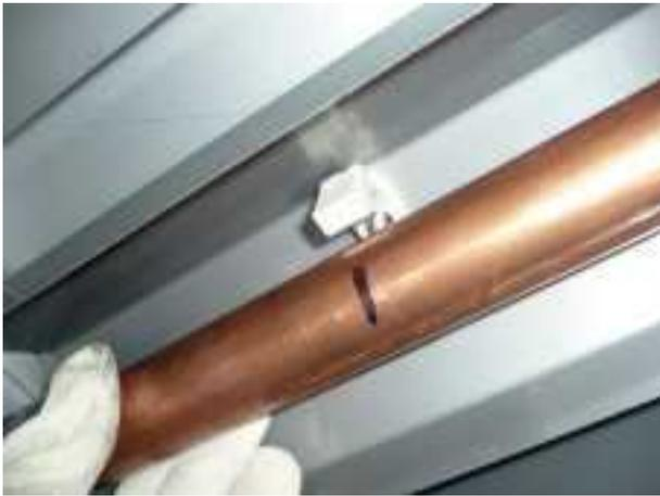
*Ausrichtung des Wasserzufuhrrohrs*
