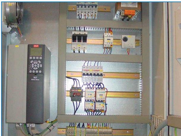
Bedienfeld mit Antrieb mit variabler Frequenz
