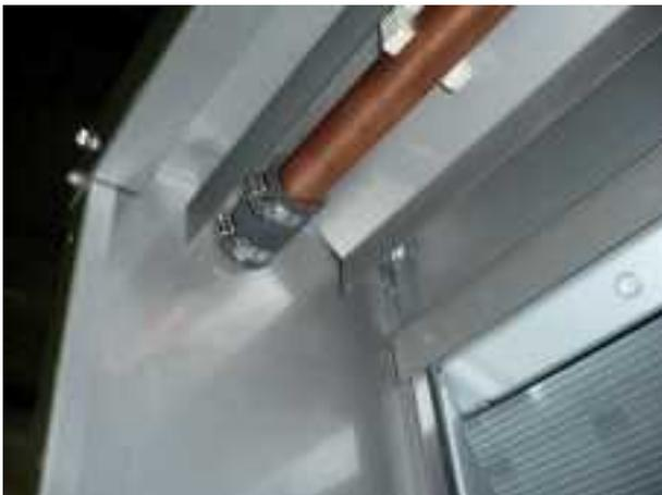
*Flexible Schlauchverbindung mit Schlauchklemmen*
