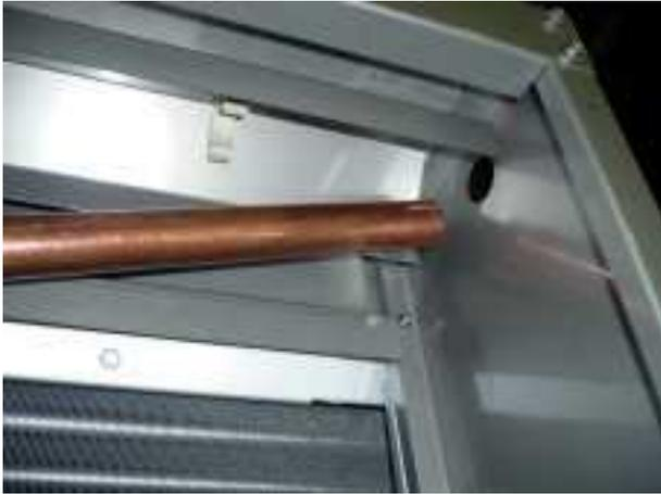
*Einbau der Kupferwasserzufuhrrohrs*
